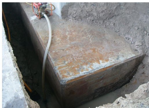
写真-7 試掘後のフーチング全景
