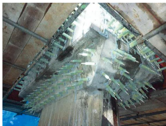
25. 橋脚補修工事
