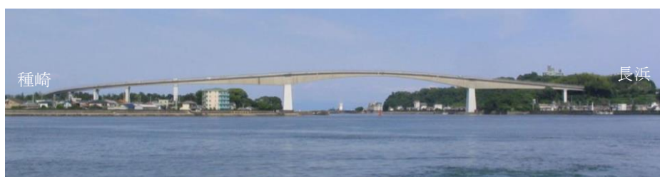
図-2 浦戸大橋側面全景
