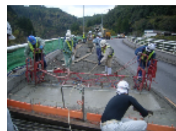
図-10 簡易フィニッシャーによる機械化施工
