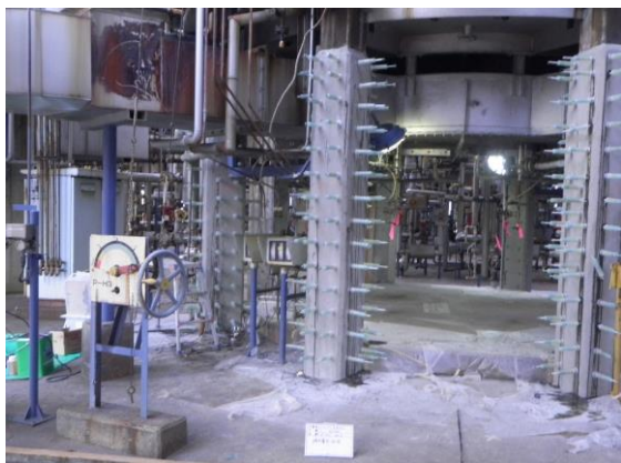
24. 基礎柱補修工事
