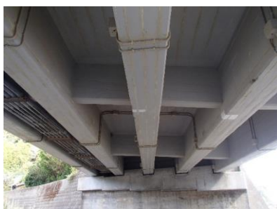
図.17 主桁・床版全景
