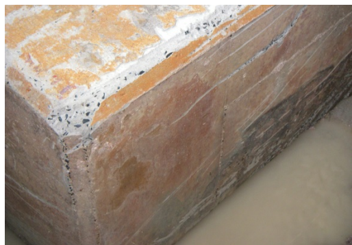
写真-8 フーチング側面 (コンクリートのひびわれ等は発生していない)
