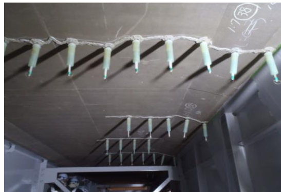
23. 床版補修工事
