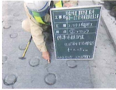
写真NO1 ひび割れ幅0.05mm
