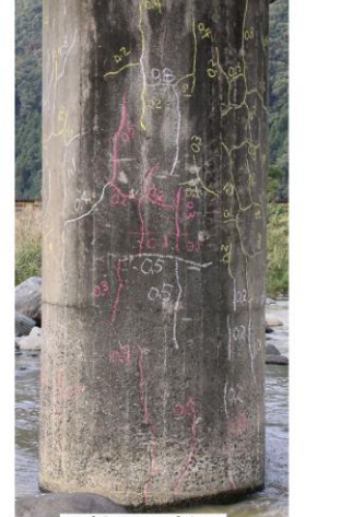
P2橋脚(上流側)
