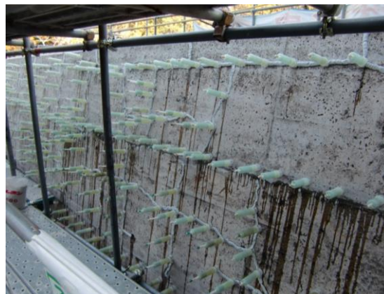
21. 砂防ダム補修工事
