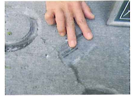
写真NO1 ひび割れ幅0.05mm
