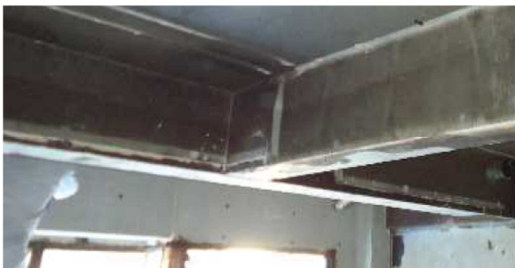
写真-2 600°C以上の高温履歴を受けた梁底の状況
