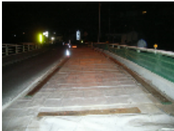
図-12 遮水シートによる養生
