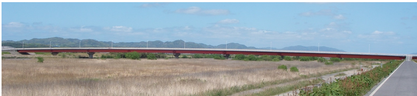
写真-2 橋梁全景
