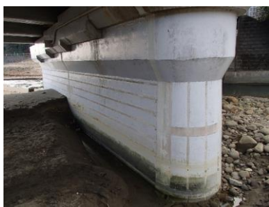
図.20 P1橋脚全景
