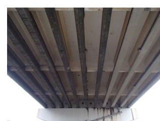
図.11 電気防食適用部
