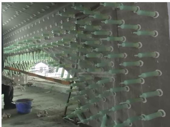
20. 高架下補修工事
