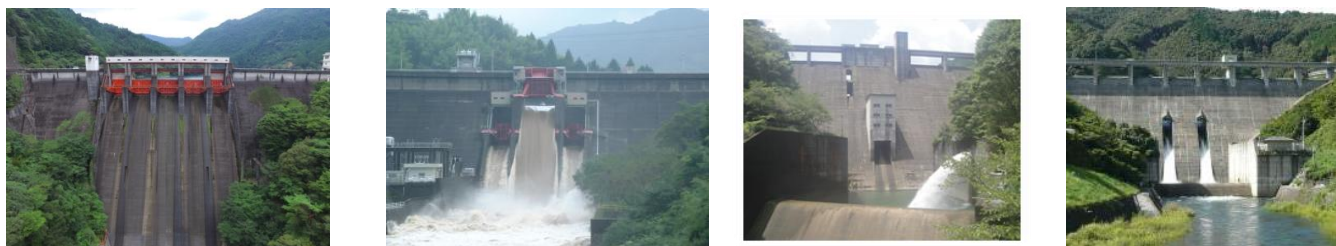
図-5 県管理ダム（左から永瀬ダム、鏡ダム、桐見ダム、坂本ダム）
