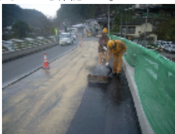
図-14 塗膜防水工
