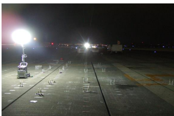
22. 空港エプロン補修工事
