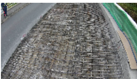
図-7 ウォータージェットハツリ工
