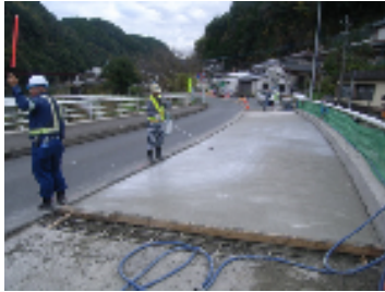
図-11 噴霧器による被膜養生材散布
